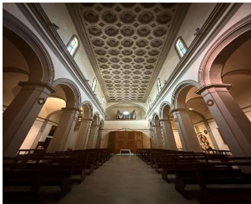
21 particolare del soffitto
